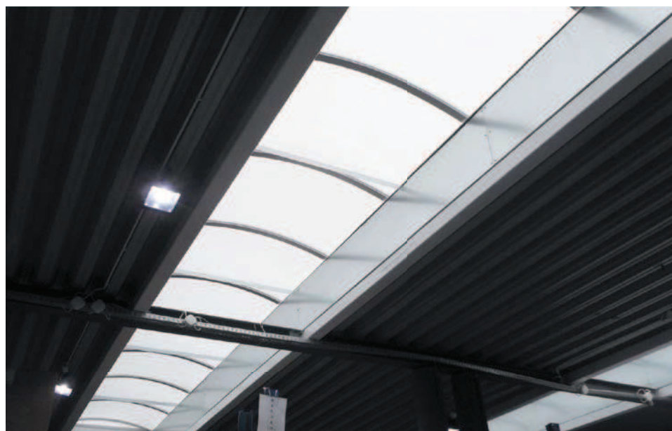
Fot. 1. Punktowe oświetlenie ledowe w hali przemysłowej doświetlonej świetlikami dachowymi. Źródło: Archiwum autorki
