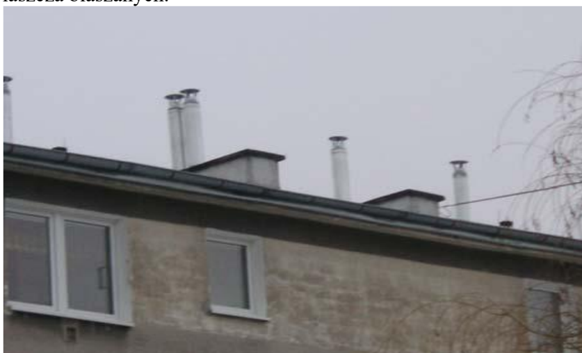
Rys. 1. Wywietrzniki i wyloty kanałów dymowych zakończone niewidocznymi na fotografii prętami zwiększającymi wysokość konstrukcji do 1,4 m
