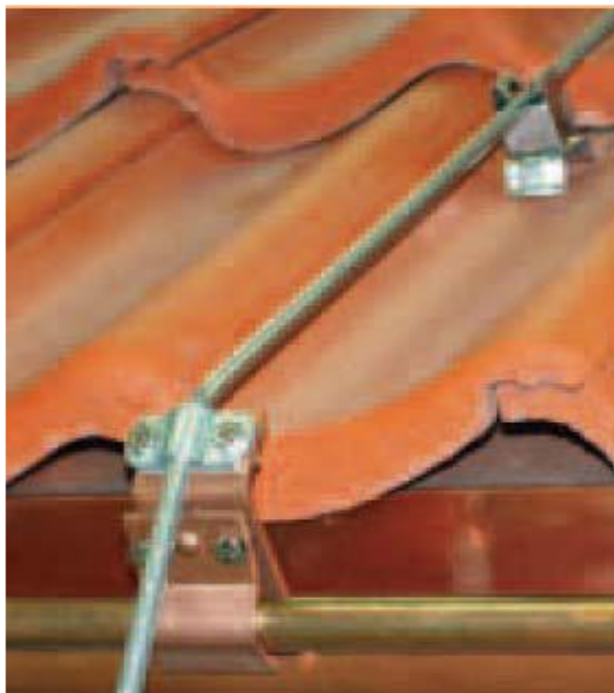
Rys. 2. Poprawne użycie zacisku dwumetalowego Al-Cu
